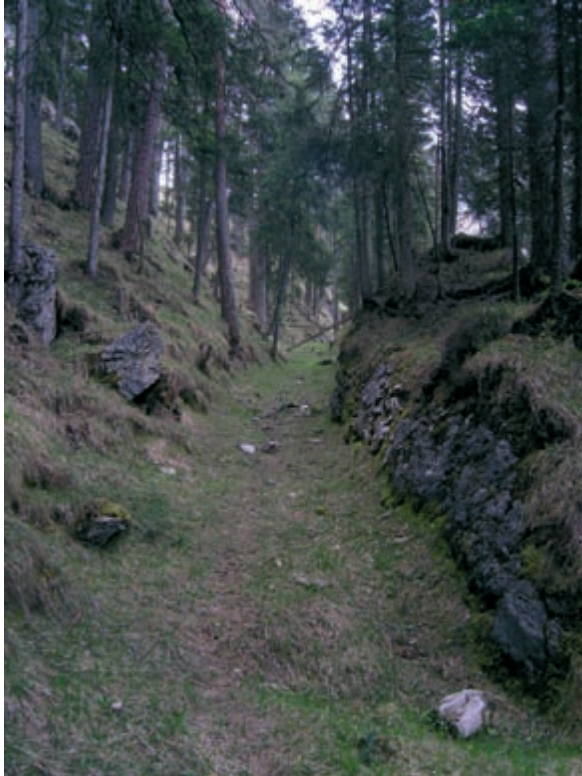
Abb. 139: Hohlwegabschnitt mit seitlicher Trockenmauer (rechts im Bild)
