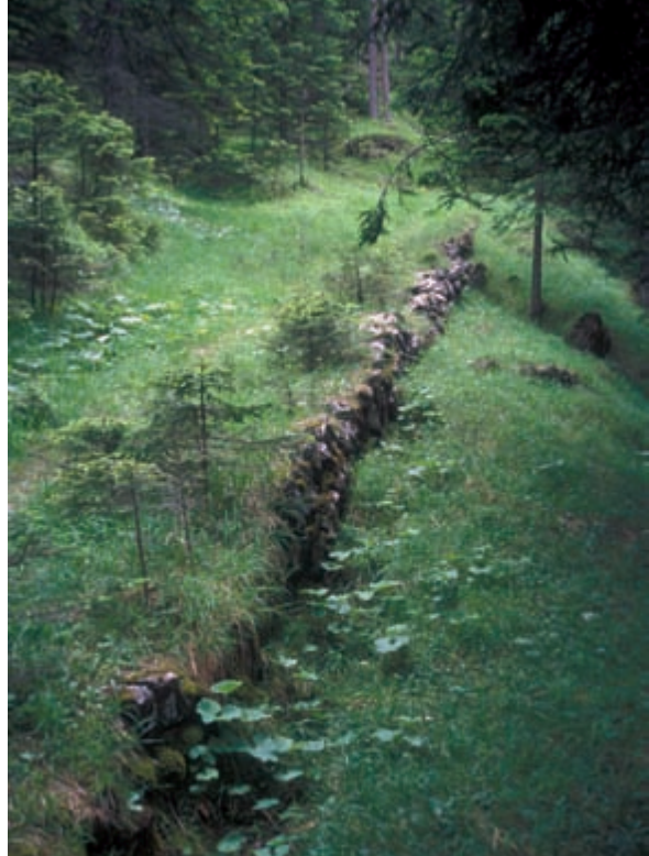
Abb. 137: Trockengemauerter schmaler Dammweg auf breiterer Hangtrasse
