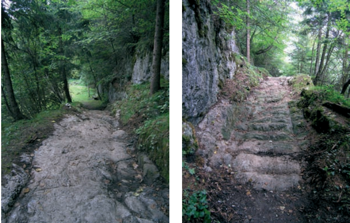
Abb. 107–108: Geleisestraße am Fuß der Kronburg mit römischer und mittelalterlicher Spurweite sowie künstlichen Trittstufen dazwischen
