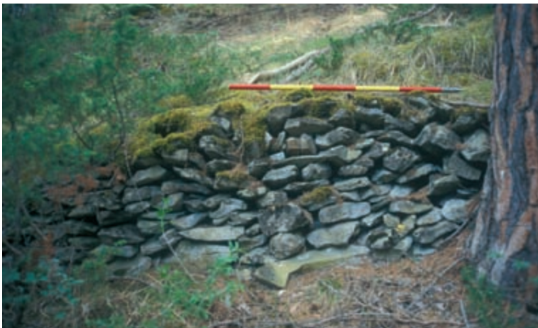
Abb. 62: Ansicht der trocken gemauerten Stützmauer in Pfunds
