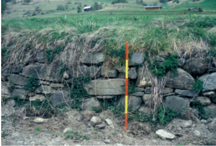
Abb. 43: Bergseitige Stützmauer nördlich von Nauders
